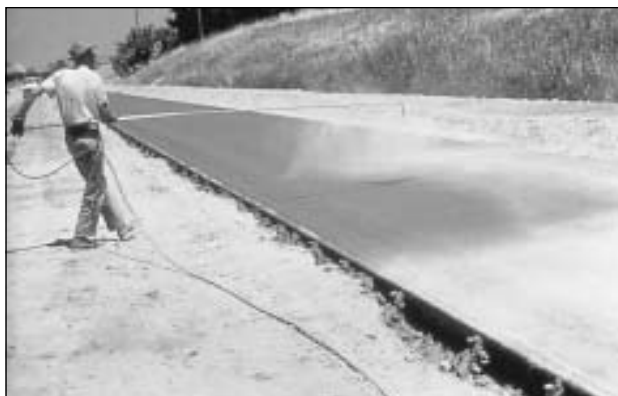
Aplicación de un compuesto formador de membrana ( curador ) con aspersor manual.
